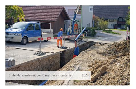
Seit dem Frühsommer wird auf 630 Metern der Strassenzug Hardstrasse und Hüttenrain in Safenwil saniert. Gleichzeitig erneuert werden dabei auch die Strom- und Wasserleitungen.
